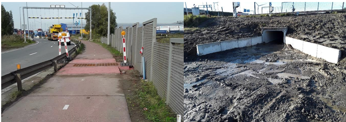
Figuur 147: De goot van de tunnel onder het fietspad (links) en de uitgang van de tunnel aan de kant van Steenlandpolder zuid (rechts)
