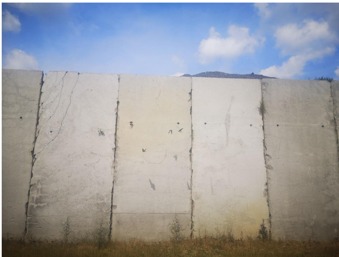
Figuur 62: Een deel van de nieuwe betonnen wand bij Recybo aan de blikken, met telkens 2 gaten per plaat. Achter de wand ligt zand, waarin de Oeverzwaluwen (via de gaten) hun nesten kunnen maken (foto: Niels De Strooper)
