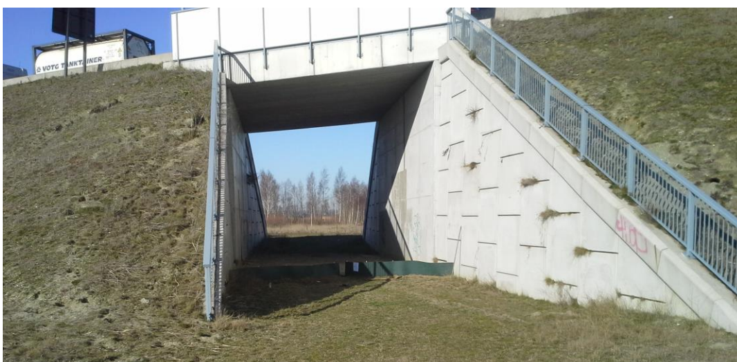
Figuur 105: Fuikvormige schermopstelling met ingegraven emmer in (toekomstige) spoortunnel
